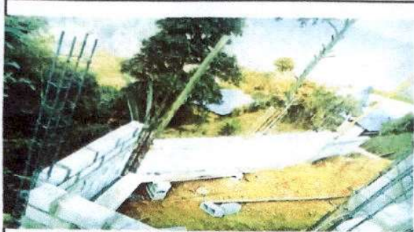
Foto 1: Reparación de muro en ejecución
