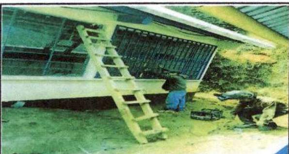
Foto 5: Colocando los balcones de metal
