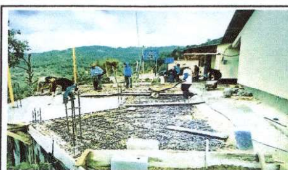
Foto 4: Reparación de muro en ejecución
